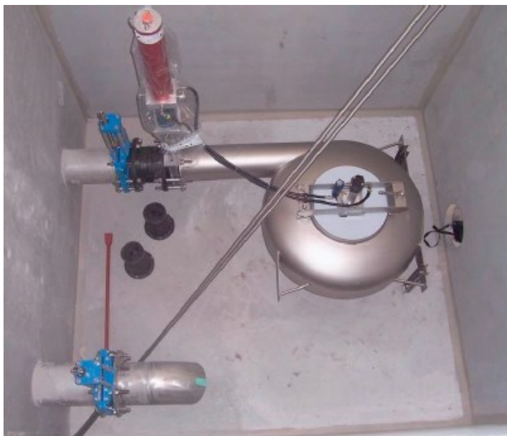
Obr.5: Namontovaný Turbo-vírový regulátor FluidTurbo DN150 v betonové šachtě. Chybí odtokový žlábek a ovládací tyče k deskovým šoupátkům.
